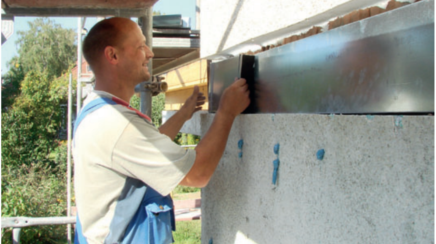
Hermetisch abgedichtete Gebäude müssen gelüftet werden – sonst droht letztlich Schimmelbildung. Forscher der HTWK Leipzig entwickeln zusammen mit Industriepartnern eine Lüftungsanlage, die sich flexibel nachrüsten lässt – weil sie in die Außendämmung integriert ist
